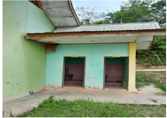
WC di SMPN 004 Kerumutan
