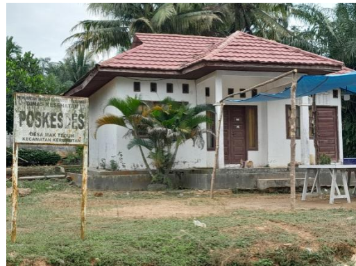
Gedung Poskesdes Dusun I
