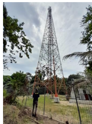
Tower Jaringan Telekomunikasi
