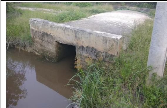
Box culvert perkebunan dan perumahan sungai medang
