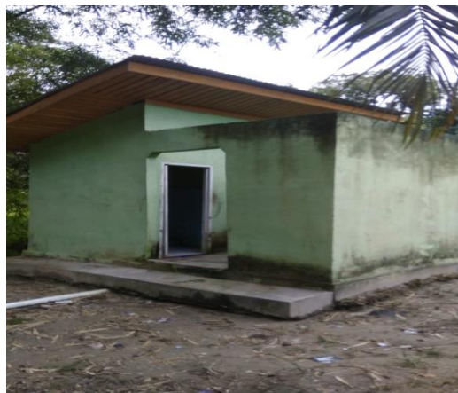
Toilet umum/ MCK
