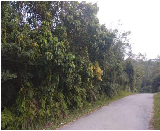
Jalan Kolektor kantor Camat Bunut
