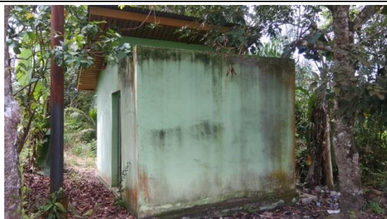
Toilet umum/ MCK
