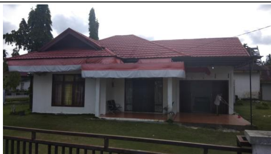
Rumah dinas camat bunut
