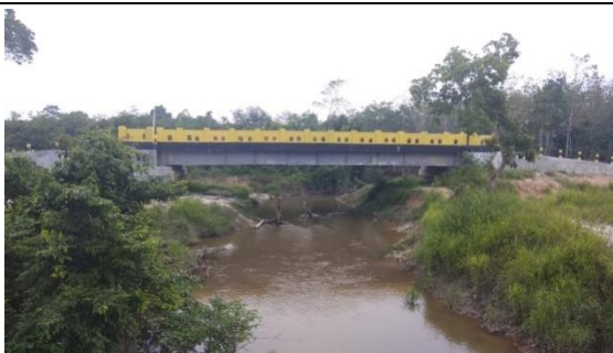
Jembatan Sungai Kapojan
