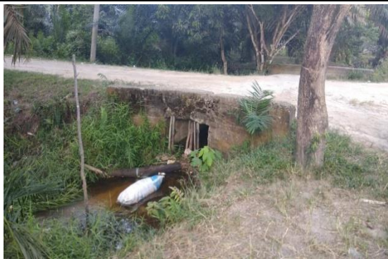
Box culvert perumahan Sungai Medang
