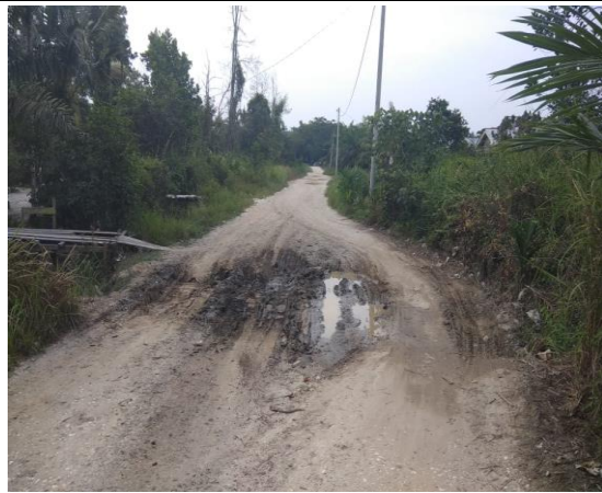
Jalan Lingkungan ke perumahan Sungai Medang
