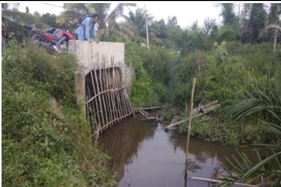
Box culvert perumahan Sungai Medang
