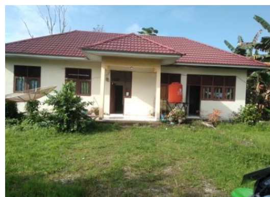
Pustu Kampung Tuah Indrapura
