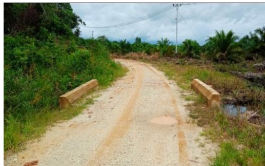
Box Culvert Jalan Pemda
