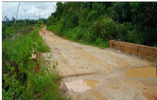
Box Culvert Jalan Pemda
