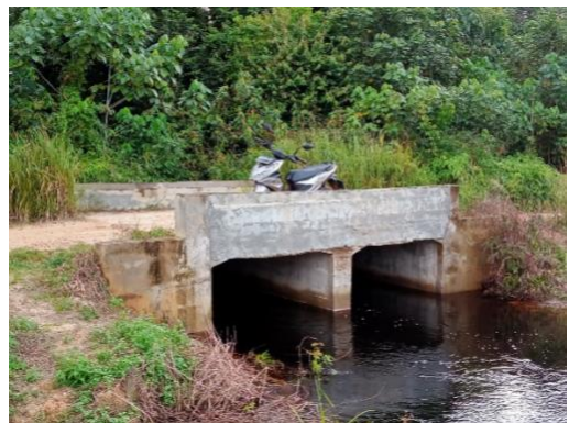
Box Culvert Jalan Pemda
