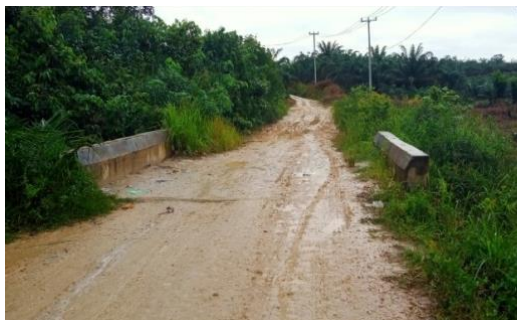
Box Culvert Jalan Pemda
