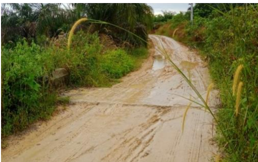
Box Culvert Jalan Pemda
