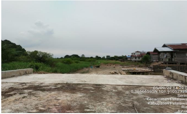
Box Culvert Dusun III
