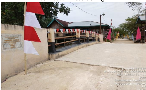
Jembatan Desa Sering Dusun III
