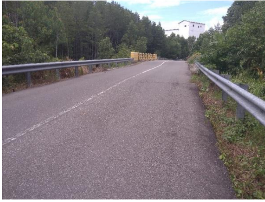
Jembatan Sungai Bunsur
