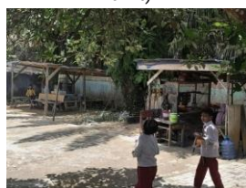
Kondisi 2 unit kantin swadaya
