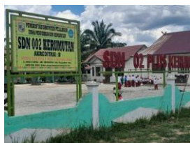
SDN 002 Plus Kerumutan (Tampak Depan)
