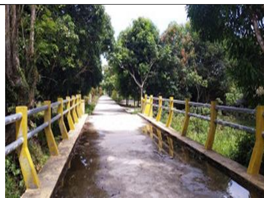
Jembatan Sungai Kuras Dusun 1
