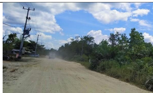
Jalan Litas Bono yang tidak beraspal
