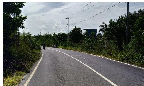
kondisi Jalan Lintas Bono yang beraspal
