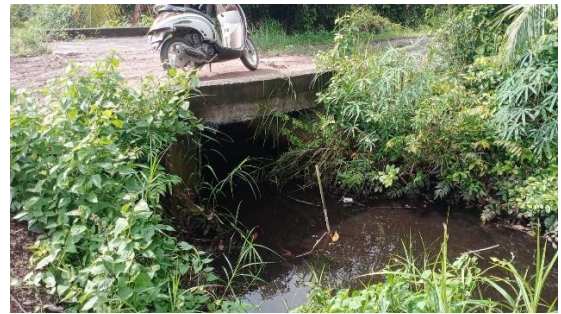
Box Culvert Jalan TK Harapan Kita
