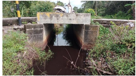
Box Culvert Jalan Inpres
