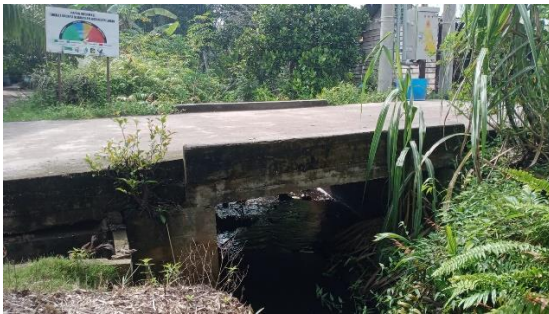
Box Culvert Jalan Kelapa
