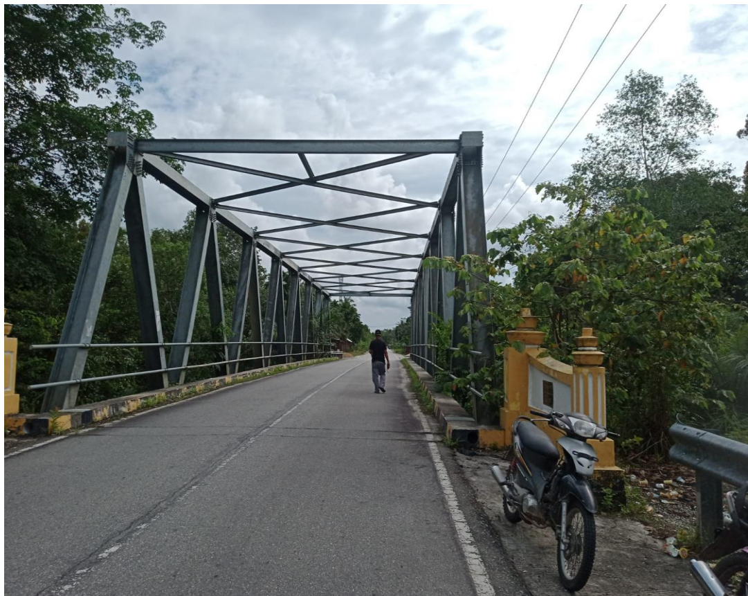
Jembatan Penghubung Antar Kampung yang dibangun oleh Pemkab Siak, berada pada Batas Kampung Sungai Limau dengan Kampung Dosan
